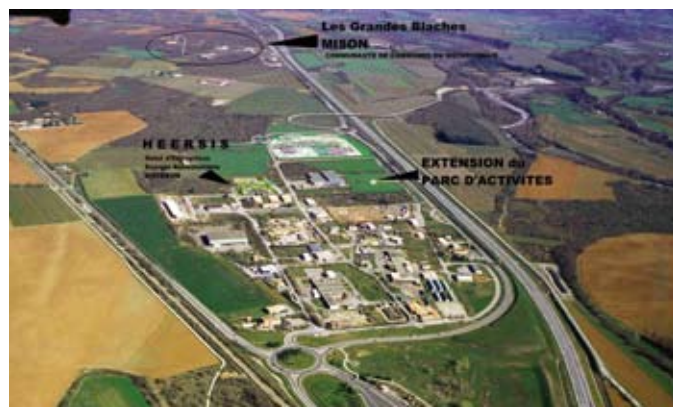
Vue aérienne de l'extension de la zone commerciale de Sisteron.
