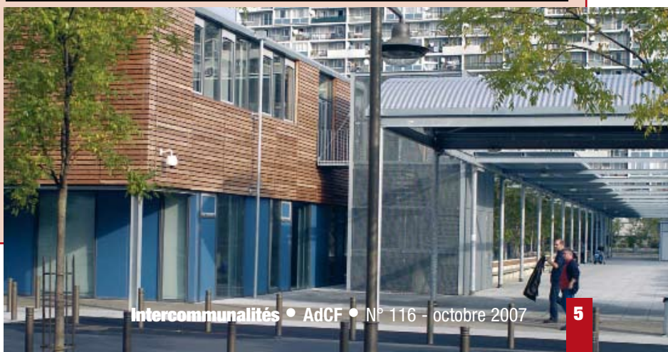
Pépinière d'entreprises de la Courneuve.
